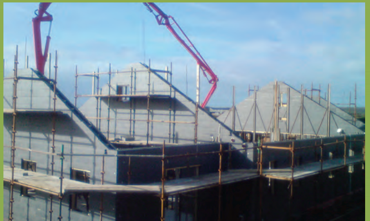
Concrete pour to ICF Walls
