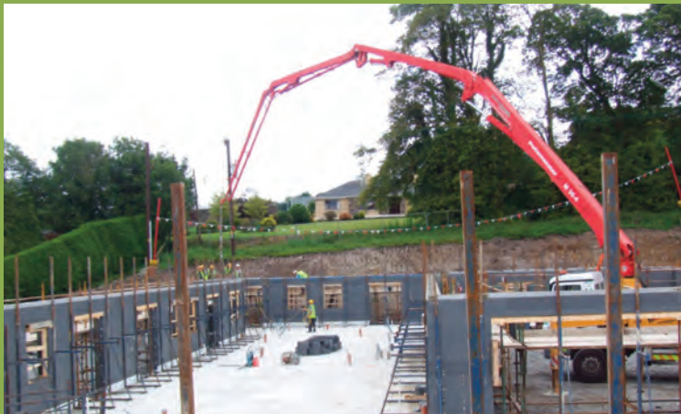
Concrete pour to ICF Walls
